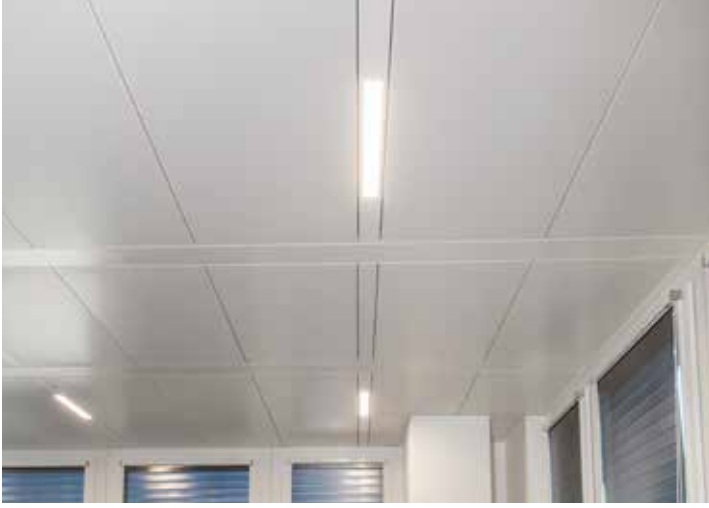
ZUGANG. Der Deckenhohlraum ist für die Installation und diverse Wartungsarbeiten einfach zu öffnen.
